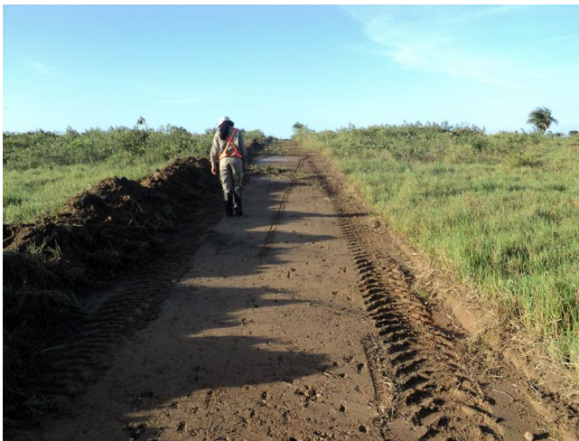
Figura 11 - Vista panorâmica das TS abertas na área da jazida.
