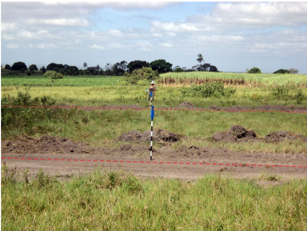
Figura 14 – Sinalização das trincheiras em campo com bandeirolas azuis.
